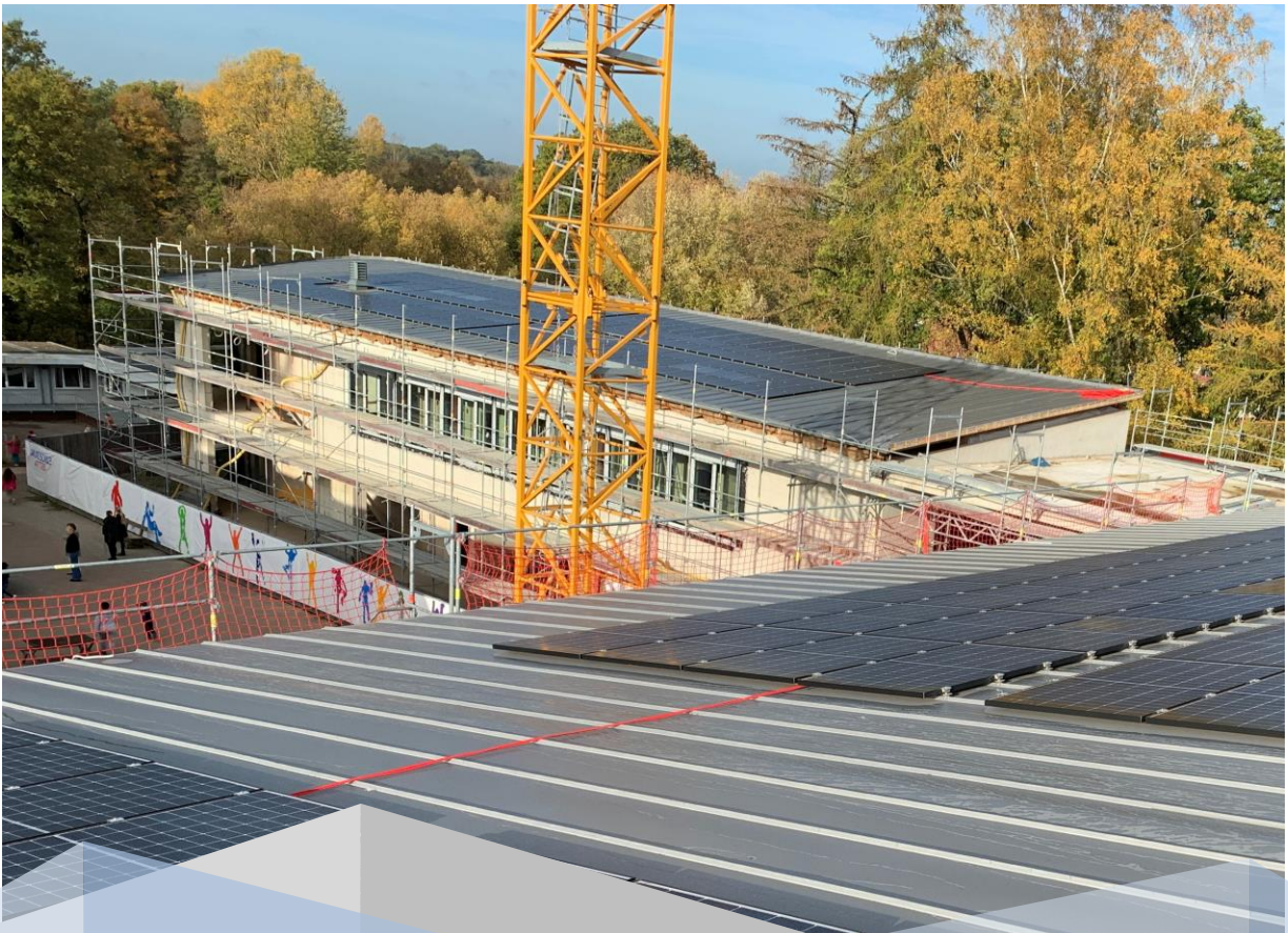
Foto: Baustelle Grundschule Atter © Stadt Osnabrück
